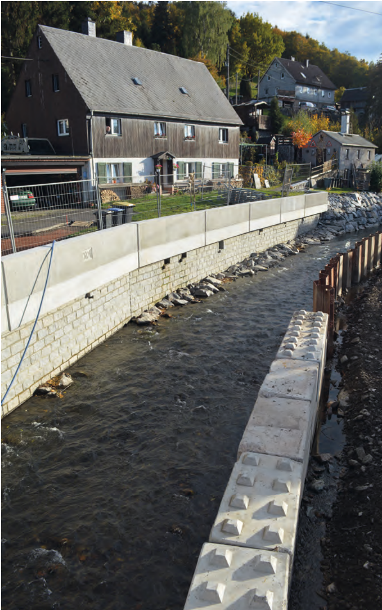
Schutz vor Hochwasser in Burkhardtsdorf im Erzgebirge
