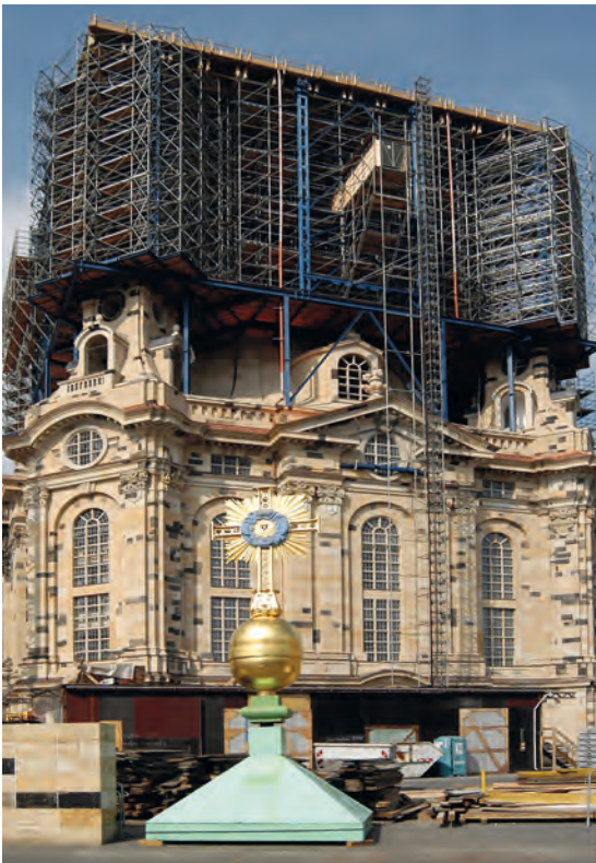
Dresdner Frauenkirche beim Wiederaufbau, 1995
